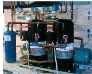
Abbildung 1. Verdichter einer Wärmepumpe
